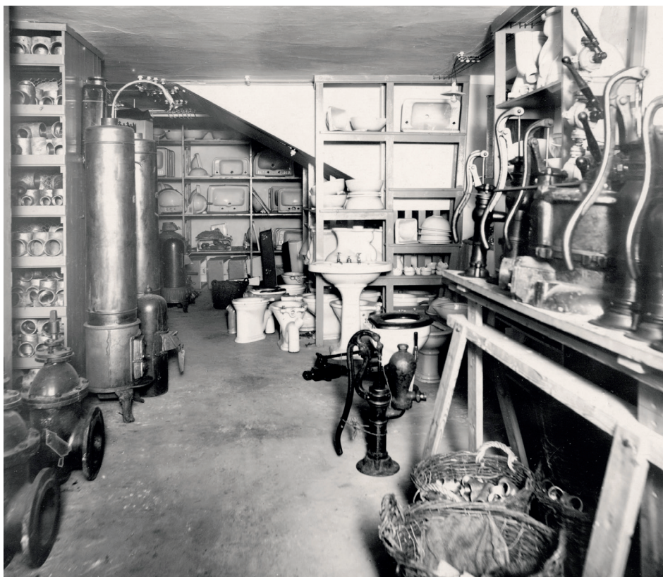
Rørhandelslageret i Møllergata 9, 1920-tallet.
